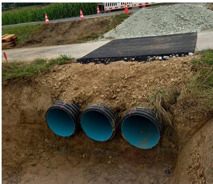
*Dieses Rohrbauwerk entlastet den Graben der B57.*
